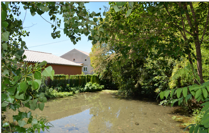
Un bassin de rétention toujours en eau au cœur d'un lotissement, accompagné de végétation hydrophile.
